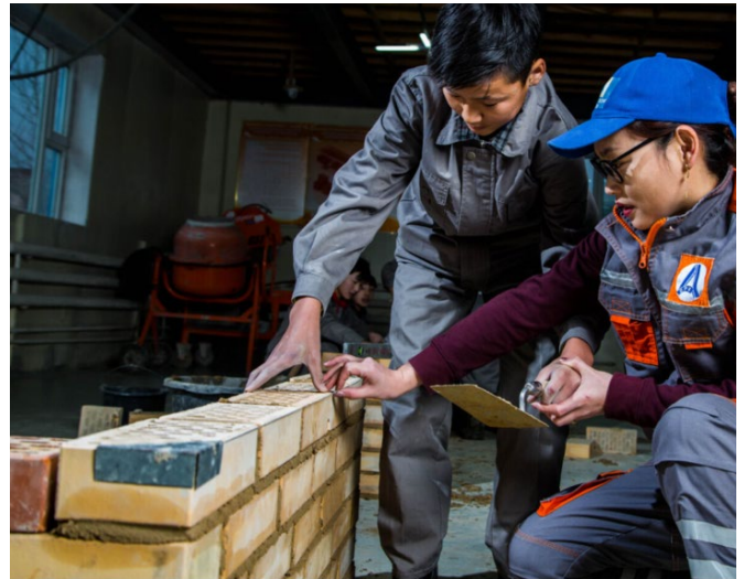
Zwei Facharbeiterinnen begutachten ein Mauerwerk.
