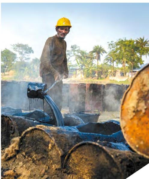
↑ Bangladesch: Ein Arbeiter kocht auf einer Baustelle Bitumen, das für die Asphalt-Herstellung im Straßenbau verwendet wird.
